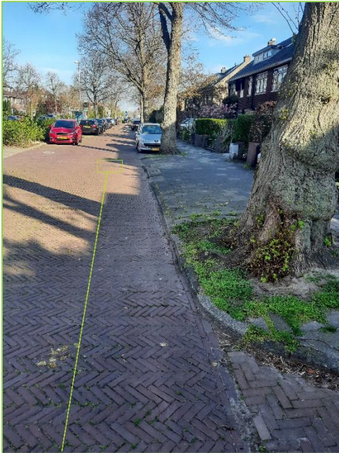
In de parallelweg ligt het riool dicht bij de bomen (groene vierkant is inspectieput, de groene lijn geeft de ligging van het riool weer).
