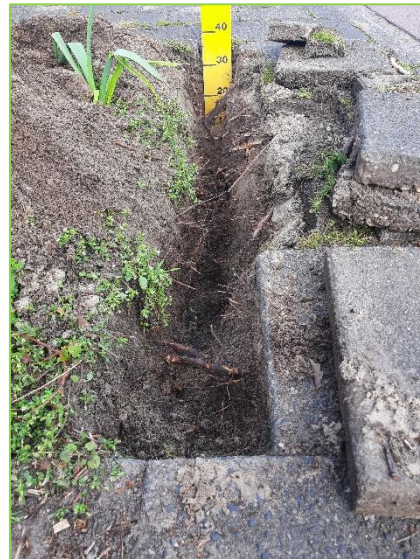
Detail van profielsleuf bij boom 20. Enkele dikke wortels en fijne beworteling.
