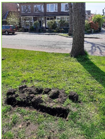
Profielsleuf bij boom 27. Ter hoogte van de sleuf komt de nieuwe bandenlijn van de parkeervakken.
