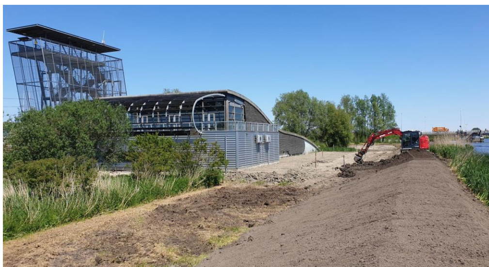
Figuur 3: Werkzaamheden aan de dijk bij het Groene Hart Centrum op 1 juni 2021
