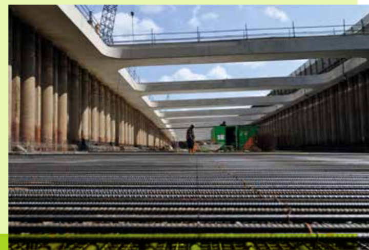
Verdiepte ligging werkzaamheden
