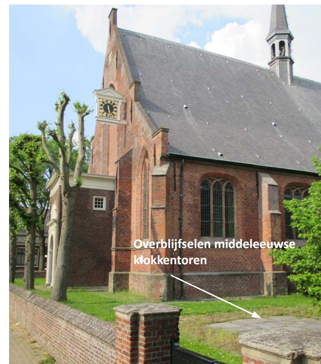
Dorpskerk uit 1620, op de locatie van de vroegere middeleeuwse kerk. Naast de dorpskerk ligt de fundering van de klokkentoren van de middeleeuwse kerk. Zowel de fundering als de dorpskerk zijn Rijksmonument.
