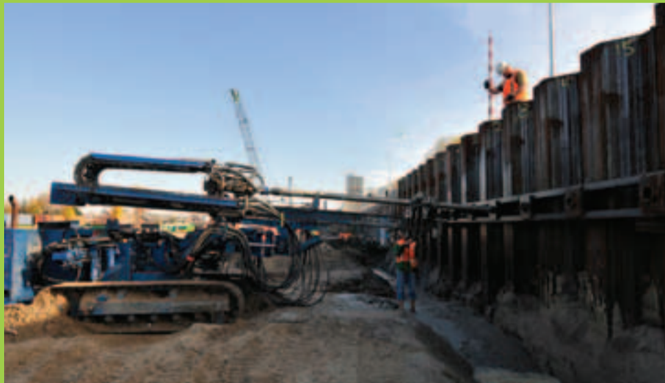
Werkzaamheden aan de damwanden. Fotografie: Johan Steenberg.
