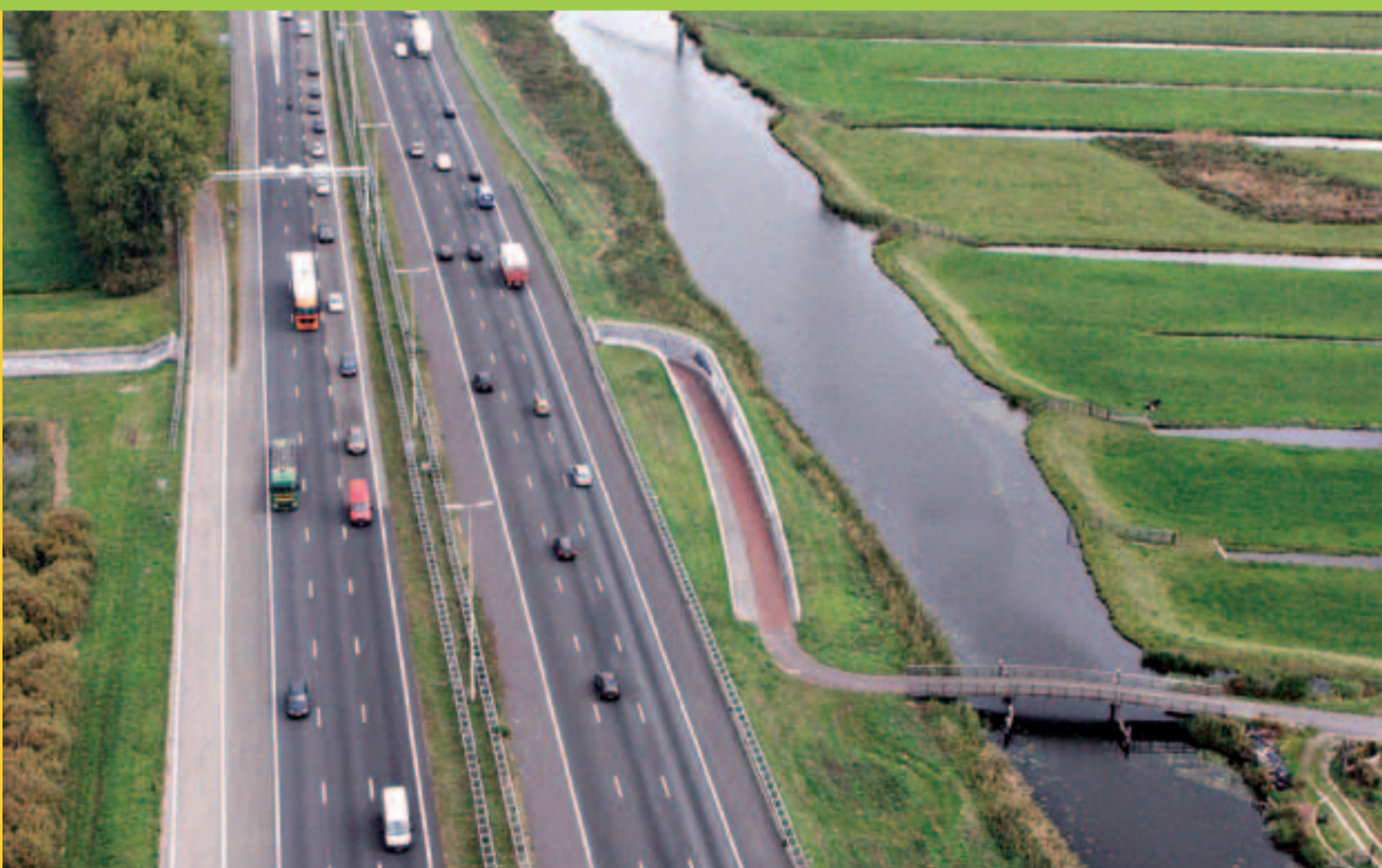
Fietstunnel Hofweg/Hofvlietweg onder A4 door vanuit de lucht gezien. Fotografie: Joop van Houdt luchtfotografie.
