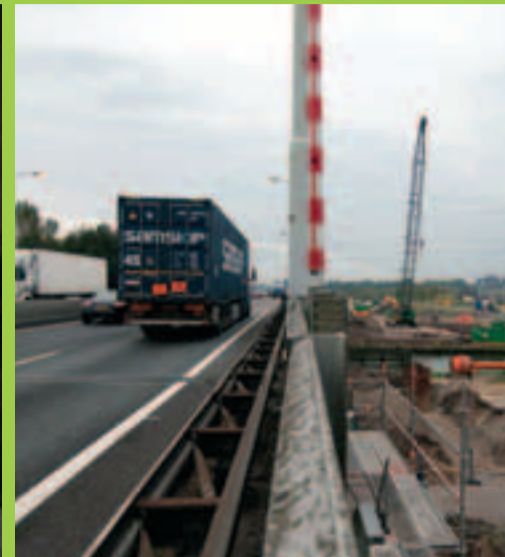
Werkzaamheden bij brug over Oude Rijn. Fotografie: Johan Steenberg.
