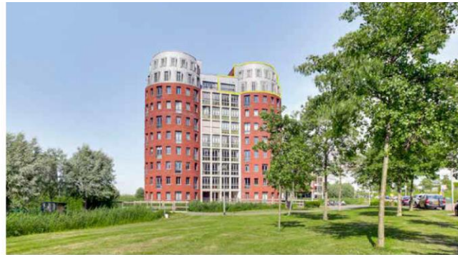
Modern appartementencomplex Don Jon in de jonge woonwijk Driegatenbrug
