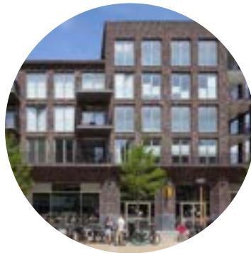
Een hogere verdieplingshoogte van de begane grond, met afwijkende vormgeving versterkt de relatie met de straat.
