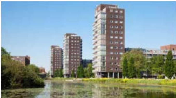
1. Vier appartementengebouwen gelegen langs Houtkamp, het centrale park van Leiderdorp (14 lagen)
