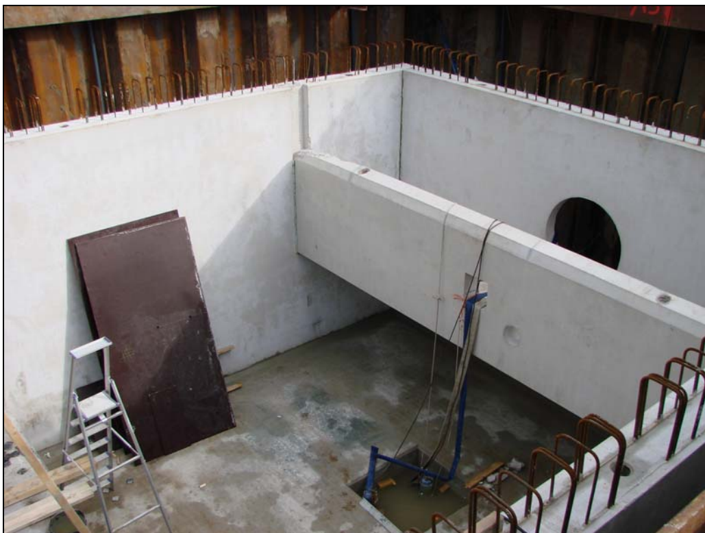
Figuur 5.6 Voorbeeld van een verbetermaatregel, aanleg van het bergbezinkbassin Van Diepeningenlaan
