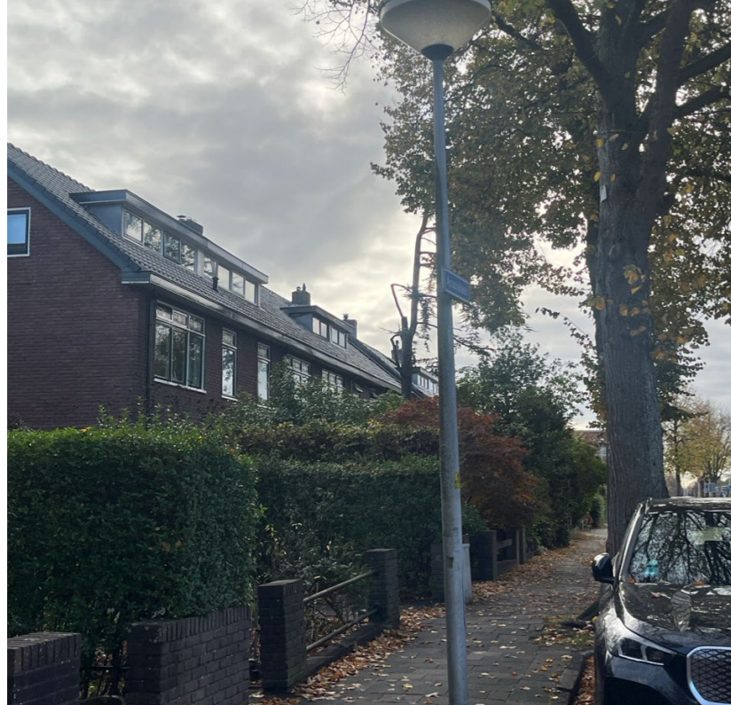
Boomnr. 11 met versmald trottoir en ontbrekende opsluitbanden. Deze situatie geldt de bomen 08 t/m 13.
