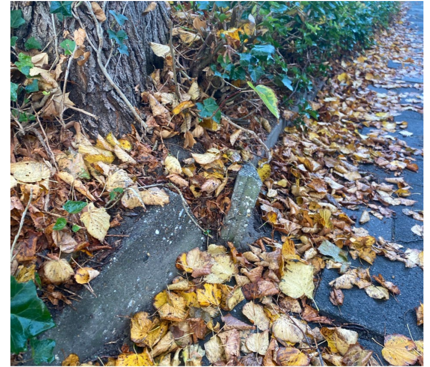
Handmatig verwijderen van verharding, hier boomnr. 2.
