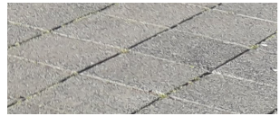
Bestaande 30 x 30 tegels
