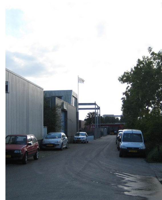
In dit scenario is ruimte voor het upgraden van het bestaande bedrijfsgebouwen (foto)
