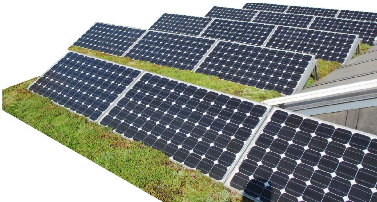
Door nieuwbouw in combinatie met een duurzaamheidsinspanning krijgt Lage Zijde een betere uitstraling
