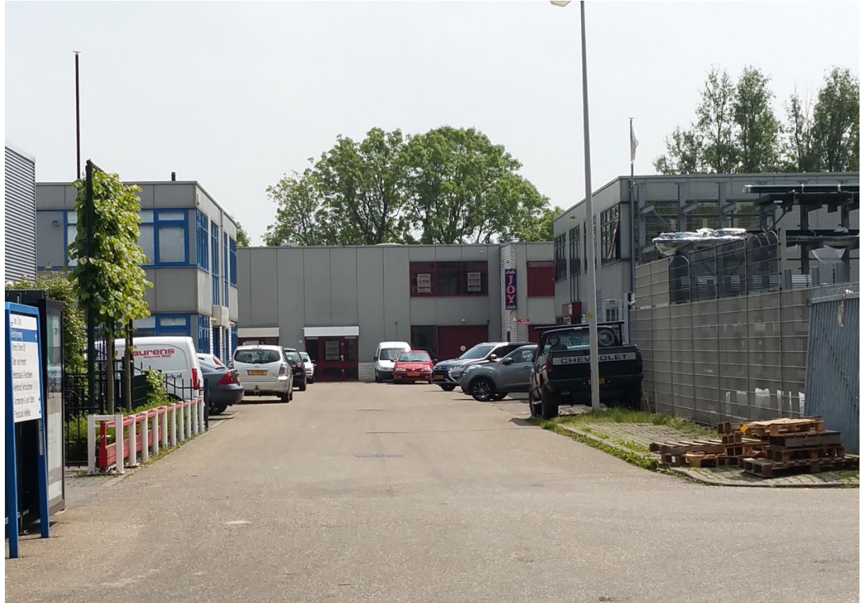
In dit scenario is ruimte voor het upgraden van het bestaande bedrijfsgebouwe
