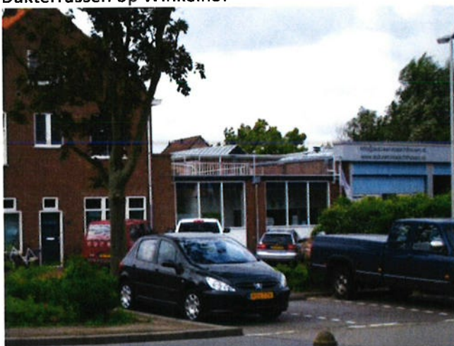
Dakterras op bedrijfsgebouw aan de Hoofdstraat
