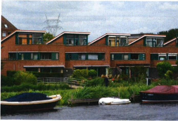
Dakterras naast dakopbouw Leyhof
