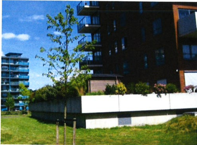
Dakterras op parkeerdek in de Schansen
