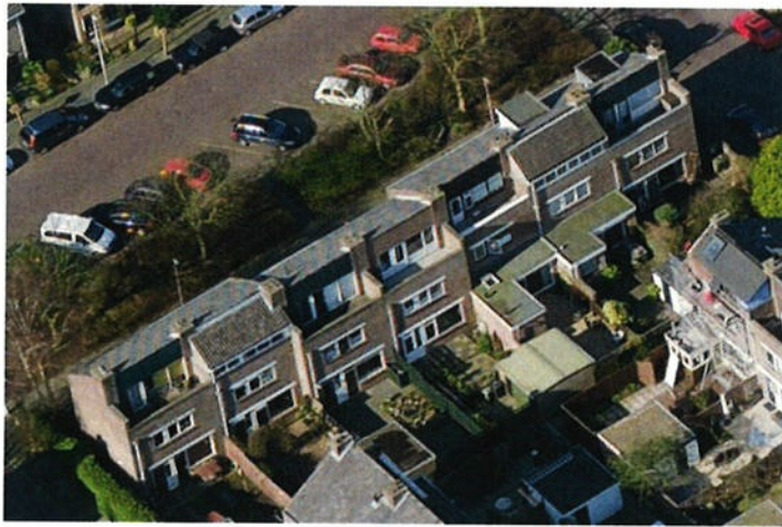
Dakterrassen in de kap Heemraadlaan
