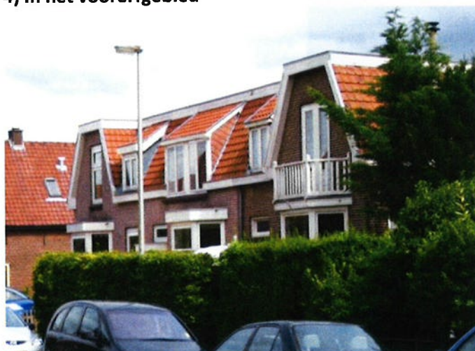
Dakterras op erker in Oude Dorp
