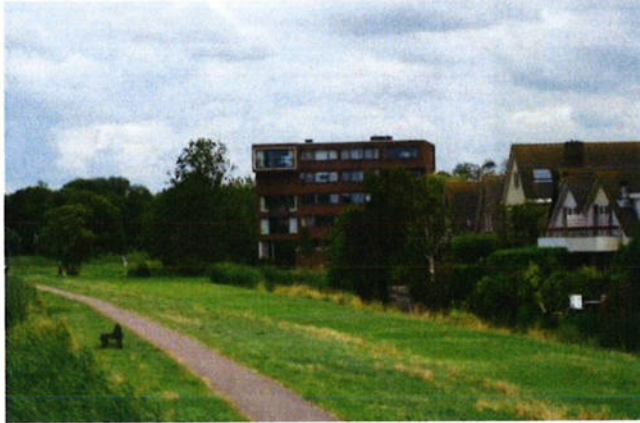
Appartementen aan Godfried Bomansstraat, dakterras op hoofdgebouw aangevraagd
