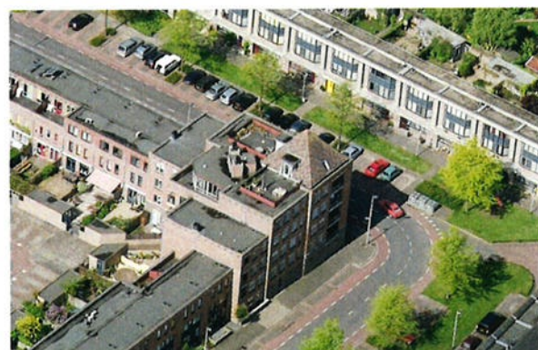
Poortwacht – dakterrassen op appartementen
