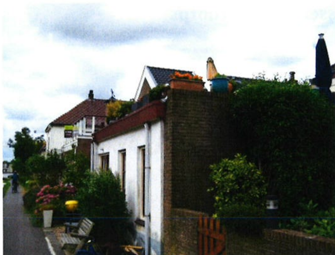
Dakterrassen aan het Jaagpad
