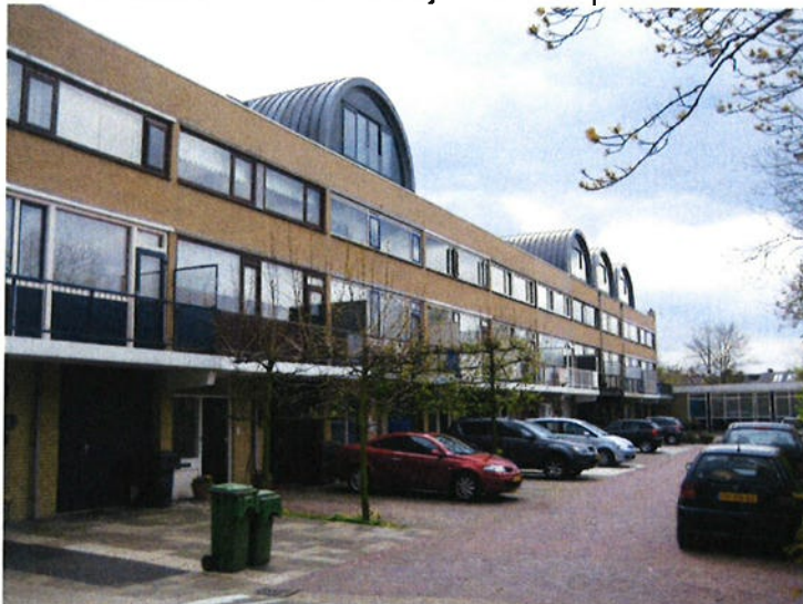
G. Qua vorm en materiaal afwijkende dakopbouw
