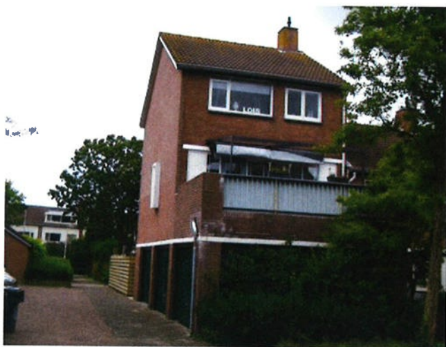
Dakterras op garages in Voorhof
