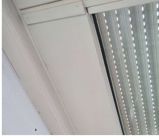
Holtlant 9: afgeschermd ventilatierooster
