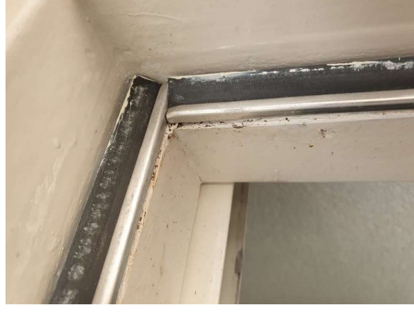
Holtlant 2: niet aaneengesloten kierdichting
