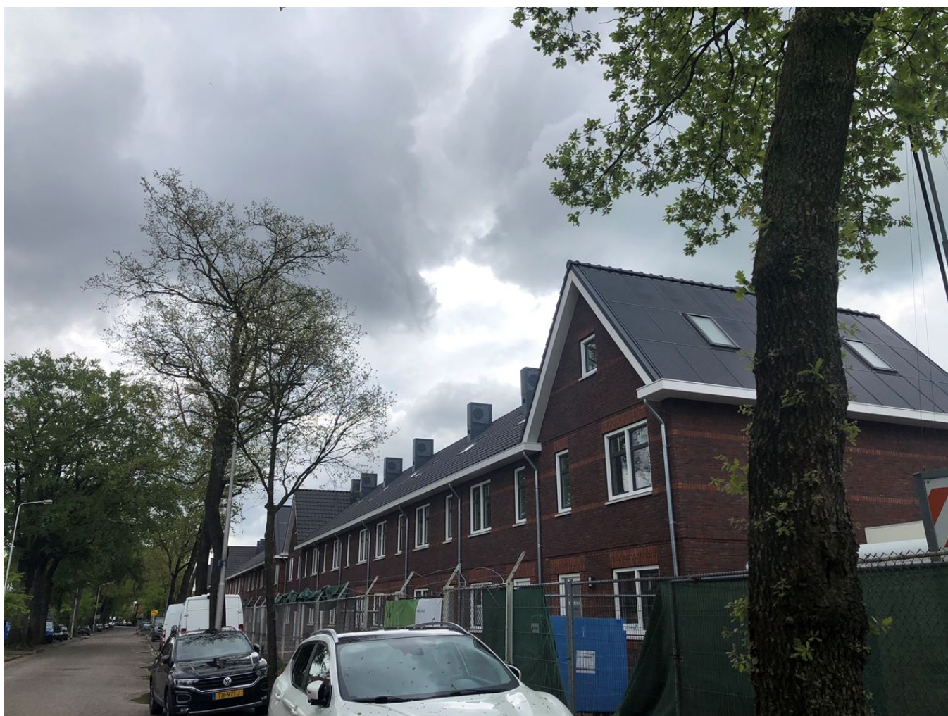
Voorbeeld van een warmtepomp ingebouwd in een schoorsteen bij nieuwbouwwoningen
